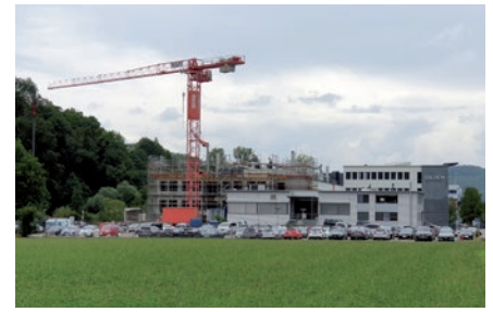
Bachem Bubendorf, Ausbau 2020 [8]
